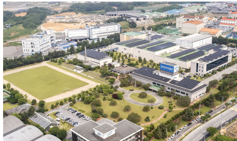
한독캠퍼스 태양광 발전 전경
