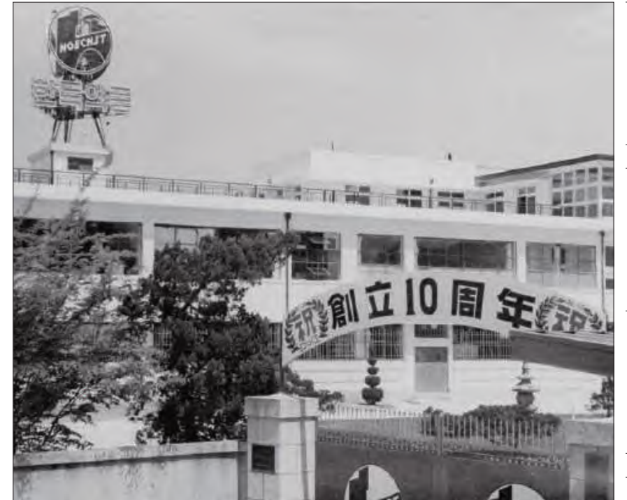
창립 10주년을 기념해 상봉동 제2공장 옥상에 설치한 한독탑. 공장 정문에도 창립 10주년을 알리는 기념 아치가 섰다. 한독탑은 이후 약연탑과 함께 한독약품의 상징이 되었다.
